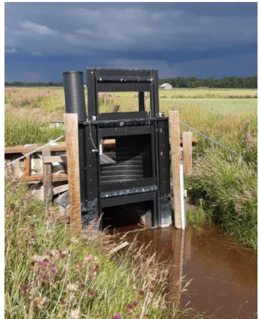
SB dam installerades år 2018. Foto: A. Bonde
