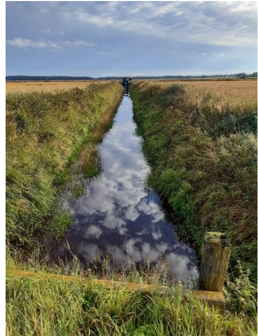
Dammen bidrar till att hålla vattenståndet högre vilket kan hålla bort växtligheten i utfallsdiken. Bild från år 2021, fyra år efter rensning. Foto: A-M Koivisto
